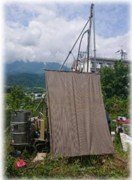
2023年6月24日 ボーリング調査の様子
